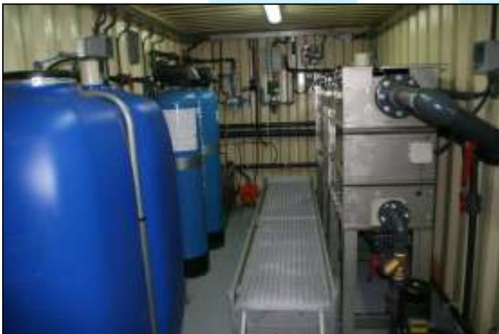
parte sobrante del caudal de agua a la balsa de acumulación. En la puesta en marcha se establece manualmente desde el PLC el valor de caudal de alimentación, dato que se podrá modificar siempre que se precise.
